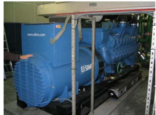
Groupe électrogène du CHR d' Orléans (1MVA)
